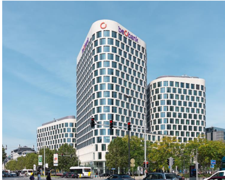
Beobank House, le nouveau siège de Beobank, se trouve dans la tour D du complexe Quatuor. Quatuor Building – SA M. & J.M. Jaspers et J. Eyers & Partners, architects.
